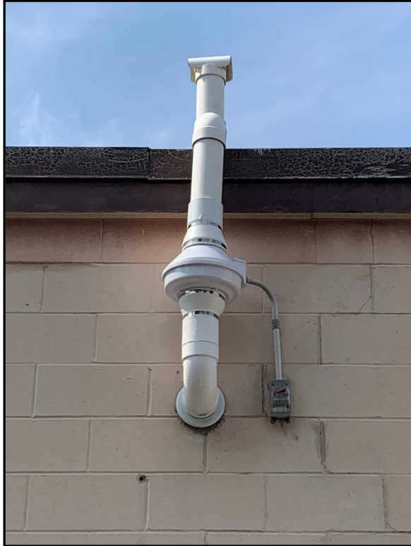
New fan installed.
