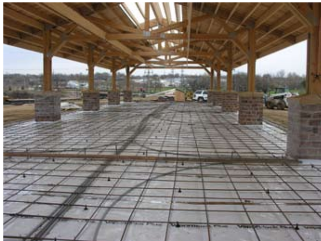
Under-Slab Vapor/Gas Retarder
