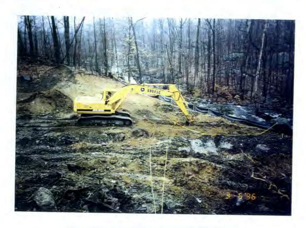
EXCAVATING FRENCH TYPE DRAIN FOR THE STREAM
