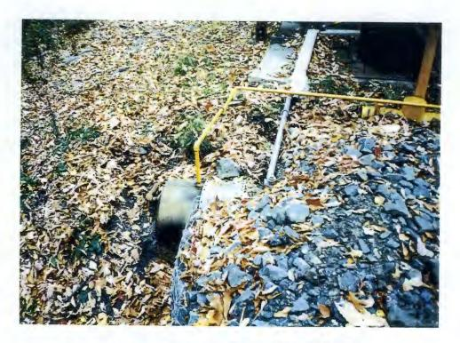
SKI SLOPE - 275 GALLON BLOW DOWN TANK FOR A COMPRESSOR
