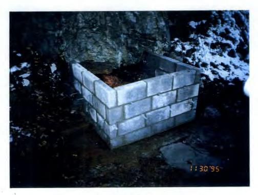
CONSTRUCTION OF CONCRETE BLOCK/BRICK COLLECTION BOX
