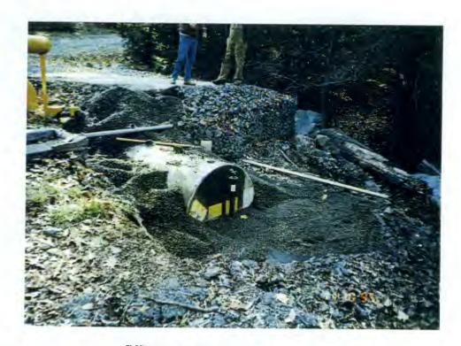
INSTALLATION OF 500 GALLON TANK AND SURROUNDING WITH PEA GRAVEL
