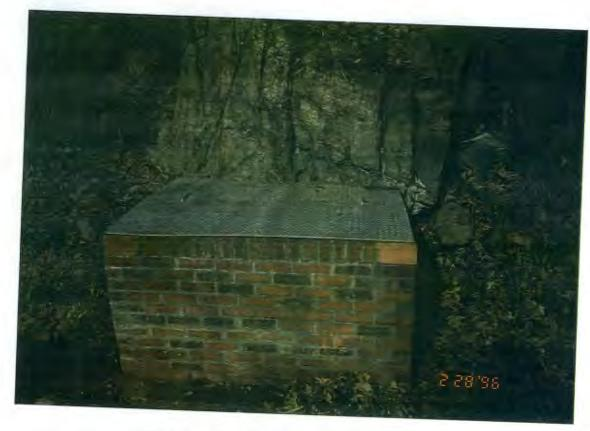
TRIMMED THE DIAMOND BACK TOP TO FIT FLUSH WITH THE COLLECTION BOX
