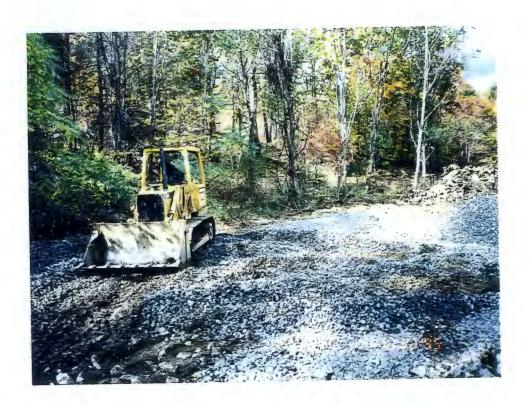
CONSTRUCTION OF STAGING PAD FOR ROLL-OFFS
