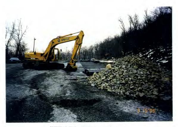
CUTTING GEOTEXTILE FABRIC LINER TO BE PLACED IN THE DRAINAGE SWALE
