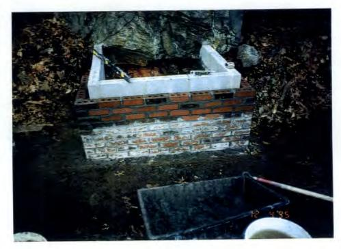
CONSTRUCTION OF CONCRETE BLOCK/BRICK COLLECTION BOX
