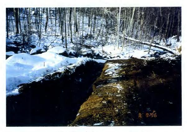
ENCLOSED RIP RAP INSIDE THE GEOTEXTILE FABRIC
