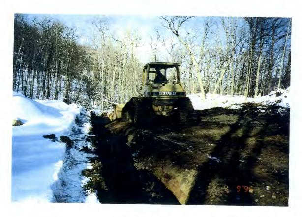
BACKFILLING THE FRENCH TYPE DRAIN
