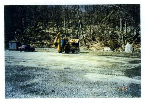
PLACING PEA GRAVEL OVER THE RE-GRADED AREA
