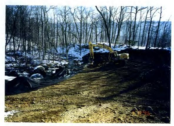
ANCHORING GEOTEXTILE FABRIC FOR STREAM BANK STABILIZATION
