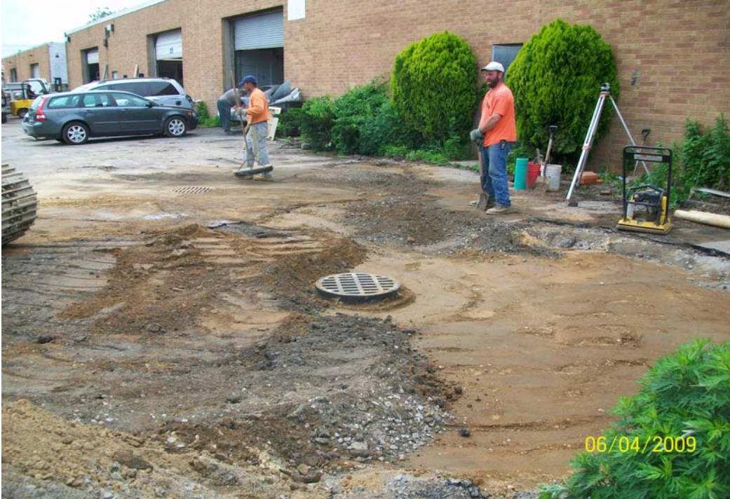
100_0760.jpg - PDS-10, 60 Dale St., backfilled
