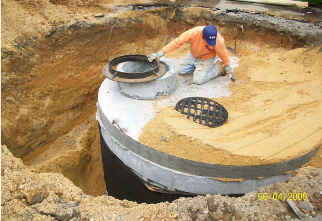
100_0758.jpg - PDS-10, 60 Dale St., installed
