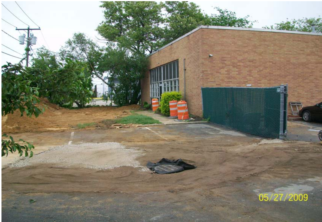
100_0707.jpg - PDS-1 backfilled, 61 Cabot St.
