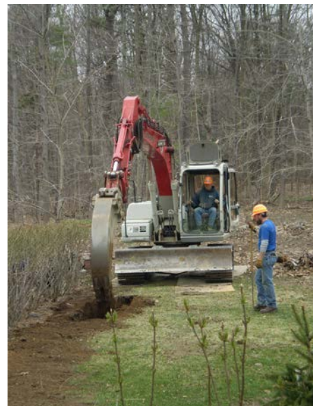
Abriendo zanjas para romper raíces injertadas
